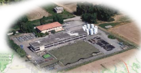
IMPIANTO MONTI DELL'ARA
